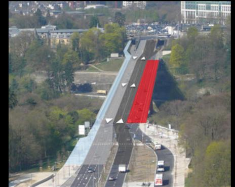
Vue en coupe du nouveau profil du pont. 26,58 m au lieu de 24,74 m précédemment. Le pont est doté des 2 pistes de roulement pour le tram, de 2 nouveaux trottoirs avec piste cyclable et de nouveaux garde-corps.
