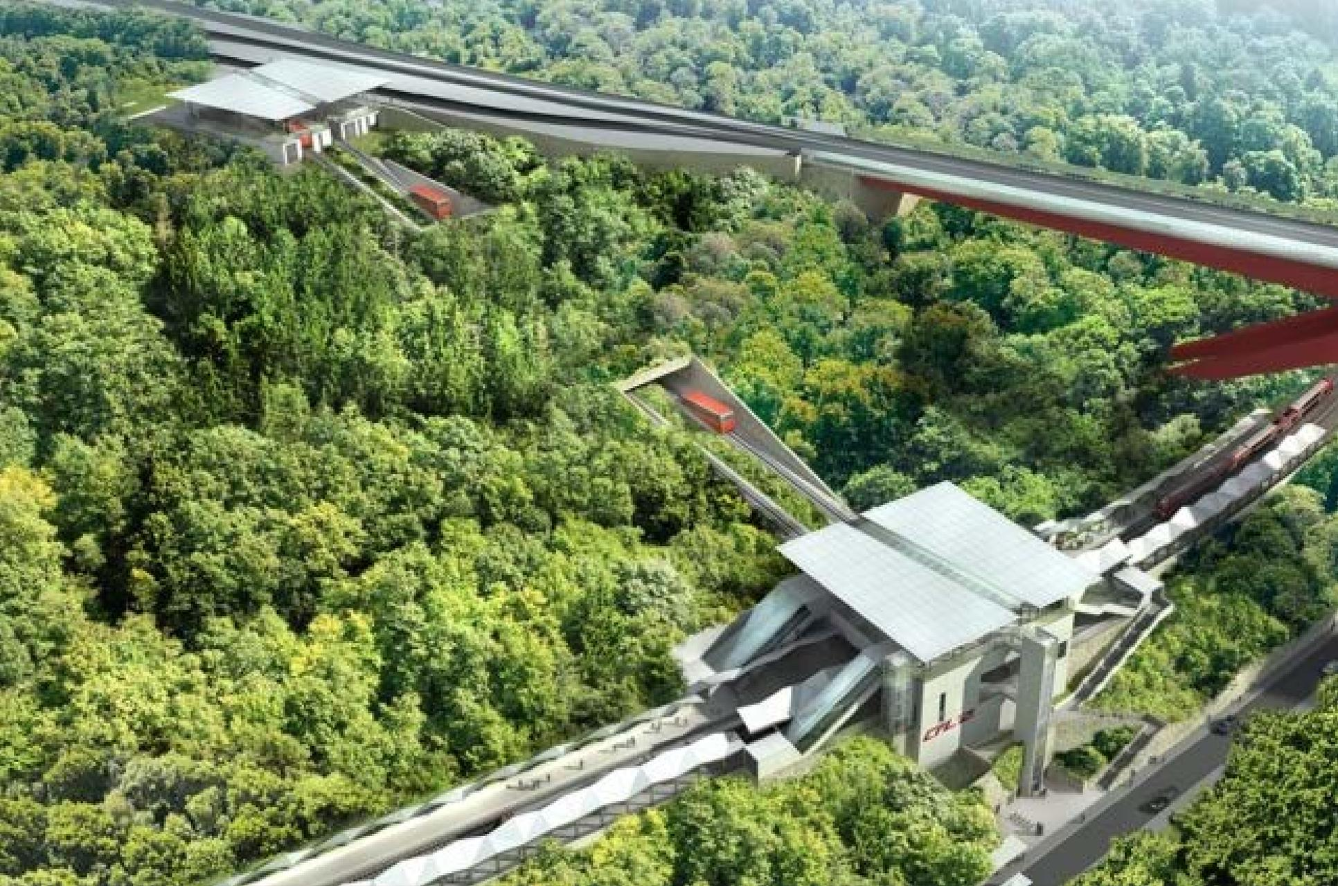
Depuis l'arrêt de train sur la ligne ferroviaire Nord, les 2x2 cabines dans les 2 sens du funiculaire achemineront 6 000 voyageurs en 1 heure environ au et du Kirchberg (chantier CFL)
