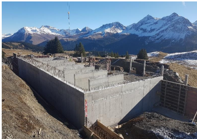
Fertig betonierte Wände des Stallgebäudes, 31. Oktober 2017
