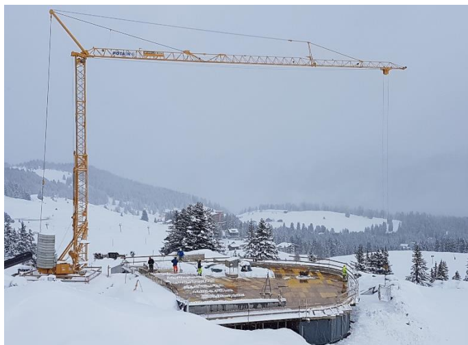
Baustelle Bärenland bei Wintereinbruch, 13. November 2017
