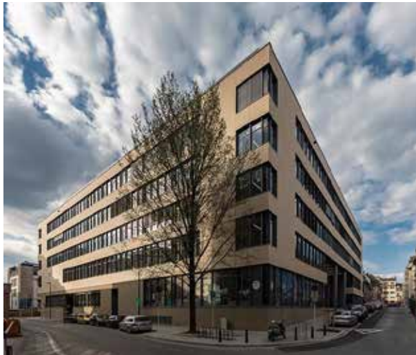
Bâtiment Mercier © POST Group
