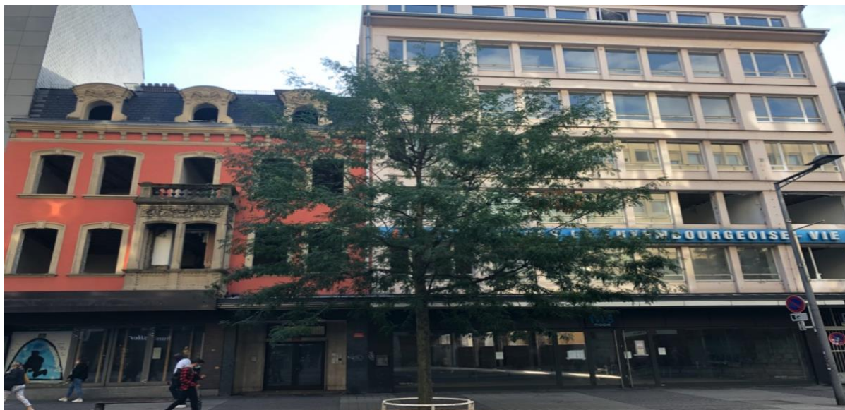
Les immeubles 49 et 51 avenue de la Gare, actuellement en rénovation (août 2020)
