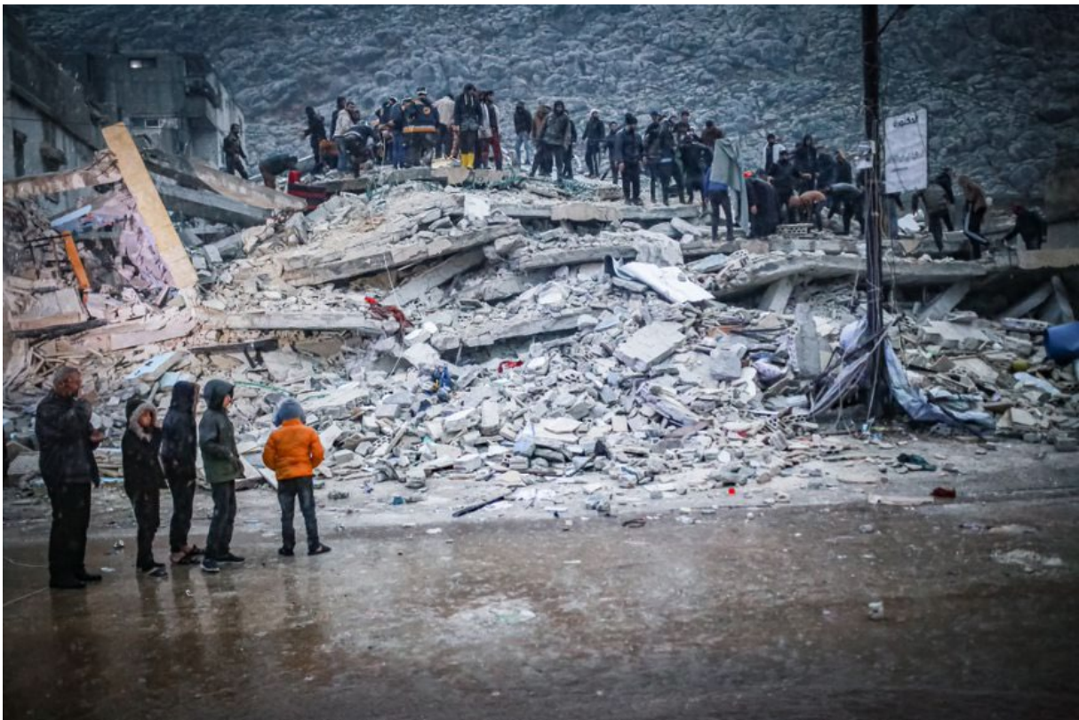
Ein eingestürztes Gebäude in der syrischen Stadt Idlib. (© Muhammed Said / ANADOLU AGENCY / AFP)
