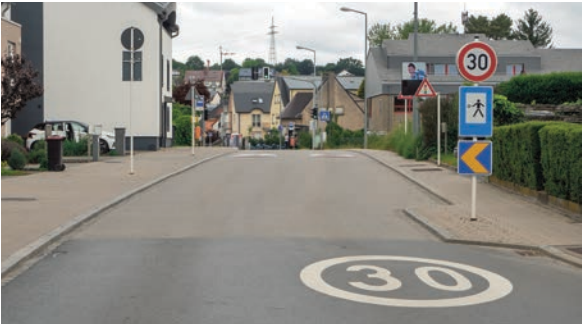
Transition de 50 à 30 km/h
