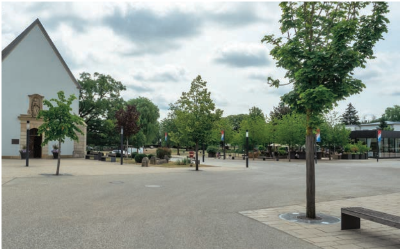
Zone de rencontre dans un centre d'agglomération
